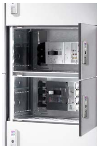
Прокладка шинной системы за секцией
